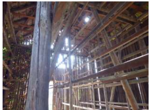
Abb. 5: Innenraum des Tabaktrockenschuppens ohne Kots Spuren von Vögeln und Fledermäusen.
