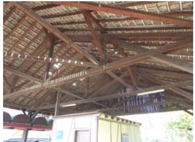
Abb. 19: Die Dachkonstruktion der Alten Wiegehalle dient wegen eines Netzes nicht als Brutplatz.
