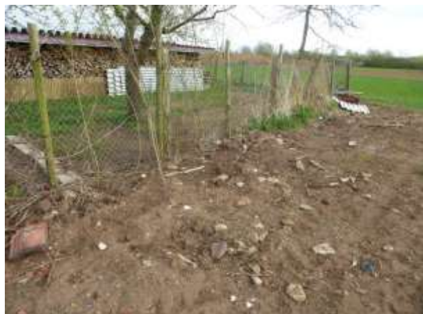
Abb. 7: Offene Bodenstellen westlich des Holzschuppens stellen potetielle Aufwärmplätze für Reptilien dar
